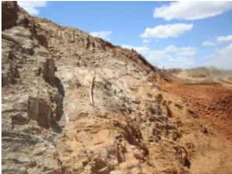
Foto 1 – Detalhe de trecho onde será implantado o *cut-off* e que deverá ser suavizado.
